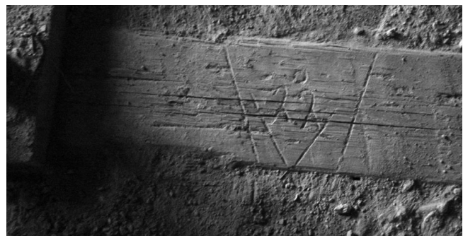
Figura 7. Vigueta en el forjado 4ª.
